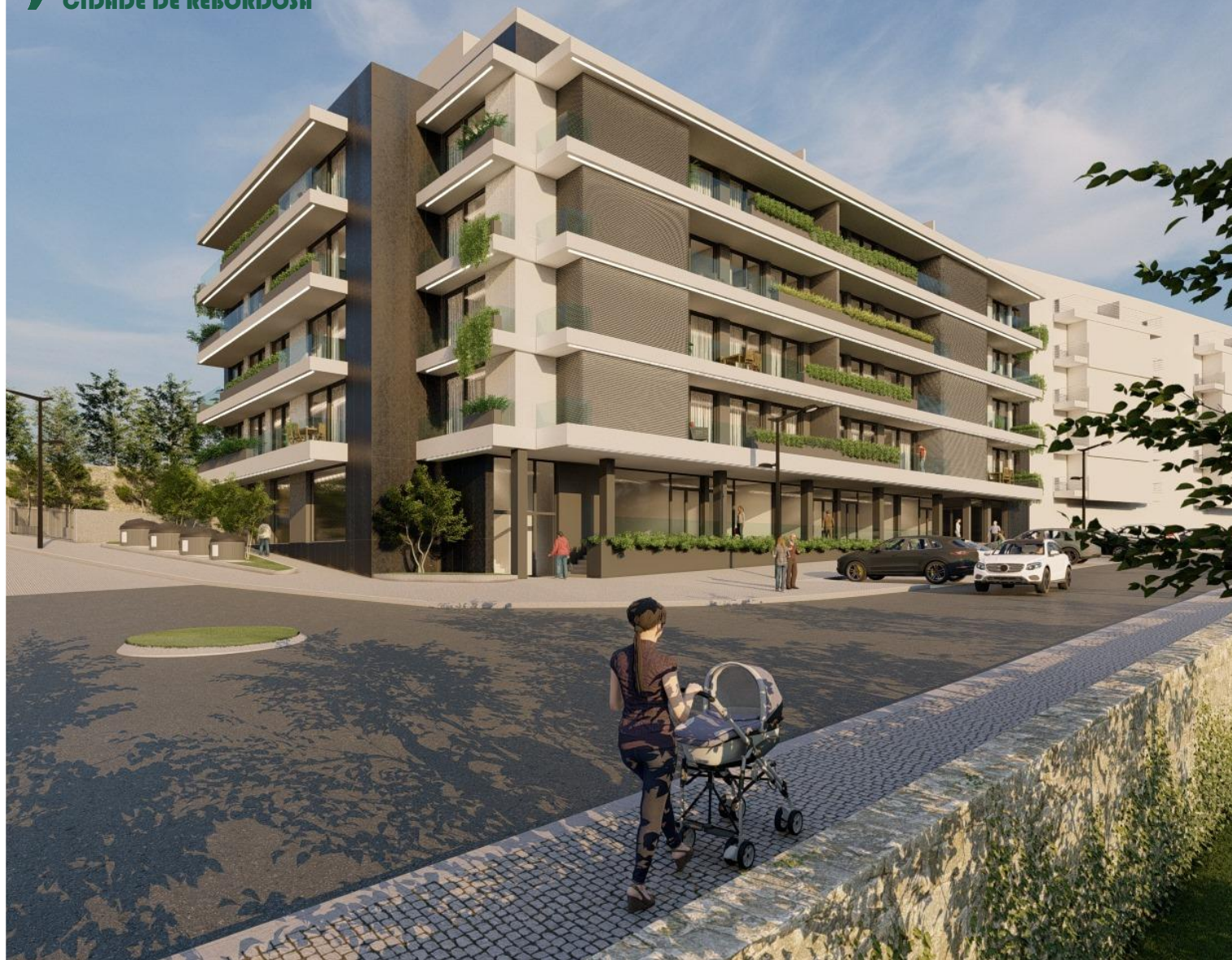
EDIFÍCIO "GENUÍNO CIDADE DE REBORDOSA" AVENIDA DOS BOMBEIROS VOLUNTÁRIOS | REBORDOSA | PAREDES
